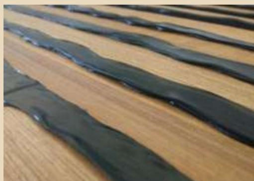
Immediatamente dopo l'applicazione, passare sul comento una spatola flessibile con un'angolazione di 30 gradi. Applicare una pressione sufficiente a fare in modo che la gomma penetri sul fondo del comento, ma lasciare uno strato di gomma in eccesso per consentire una lenta sedimentazione della stessa. Dopo l'applicazione, assicurarsi che nei comenti non sia stata intrappolata dell'aria. Non maneggiare fino al completo indurimento.
