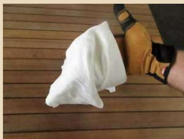
Inumidire uno straccio con acetone. Pulire e sgrassare i comenti avvolgendo il panno pulito intorno ad un utensile (es. Spatola oppure al Seam-Sander, vedi foto). Pulire con un movimento "avanti e indietro", girando spesso lo straccio. Lasciare evaporare l'acetone, poi procedere subito a gommare il cemento.
