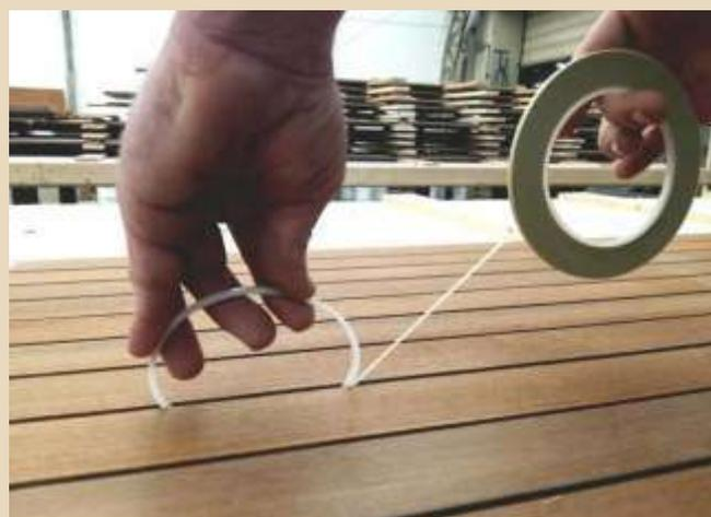
**NON UTILIZZARE PRIMER**. Per avere un risultato ottimale, usare un nastro adesivo "Bondbreaker" (Fine Line) che deve essere applicato sul fondo dei comenti prima di gommare. Questo nastro fa sì che la gomma non aderisca sul fondo del cemento.
